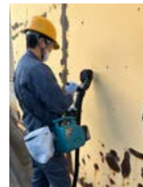
BBWコードレス+集塵カバー+集塵機 コードレスで動作しやすいです。
