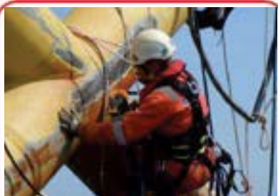
オフショア高所作業を安全、効率的に
