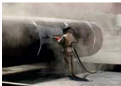
部分補修や高所作業では工具が有効
